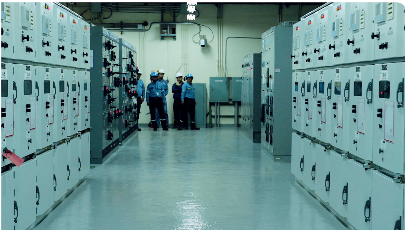
Foto 1: Refinería de Petróleo
